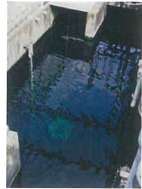
アクアセンターで 浄化された後の 工場排水
