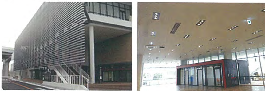
厚生棟(南面)遮光ルーバー(左)、厚生棟内照明(右)
