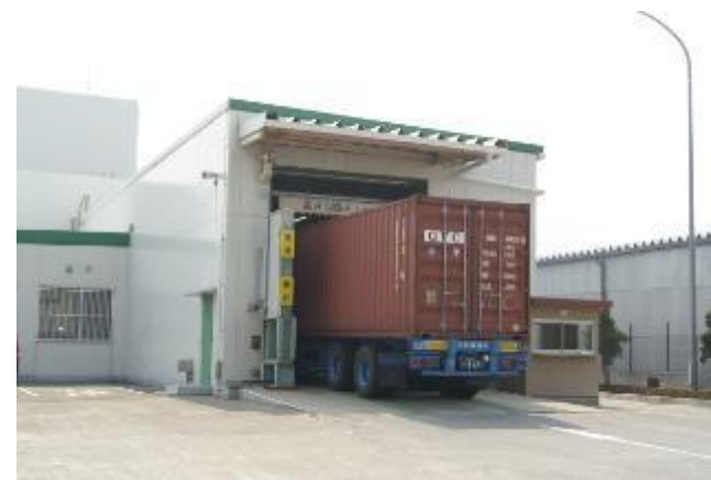
平 14.3 大型 X線検査装置の導入 トラックの荷台に搭載したままコンテナ貨物を検査する装置であり、コンテナを開披することなく検査ができるため、適正・迅速な通関が行われている。
