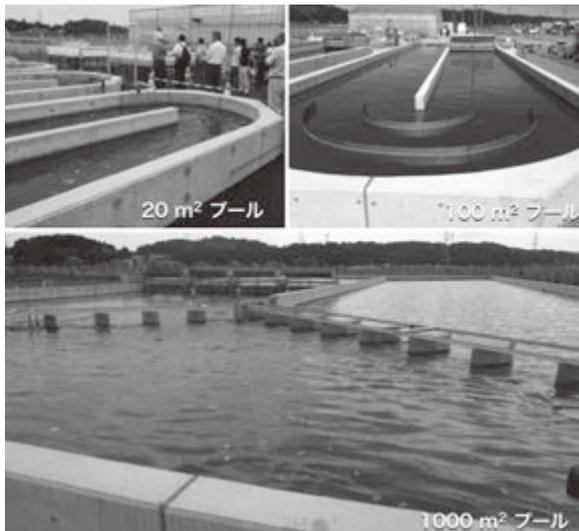
図4 南相馬市で稼働中の藻類バイオマス生産プール。1000 m<sup>2</sup>の藻類培養プールは6レーンの50m スイミングプールに相当
