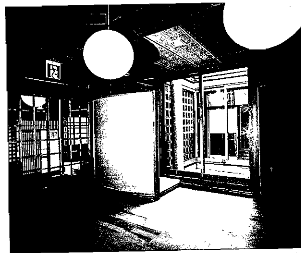
図3 耐力格子（地震に強い町家をつくるため、筋かいや構造用合板の34倍の強さを持つ耐力格子を建物の中心部と外周部に設置し、地震に対する揺れ、ねじれに耐える構造としている。この提案は、いなか設計集団および奈良の建築家田原氏の提案である。）
