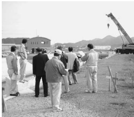
市道13098号線橋梁上部工事
