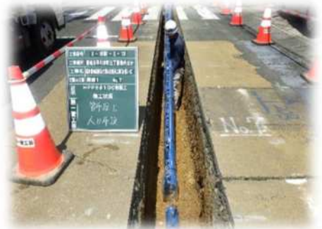
水道管耐震化工事の様子
