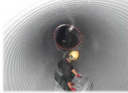
下水道管更生工事の様子
