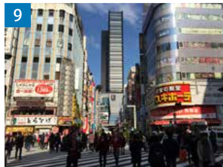
9 ○セントラルロード（靖国通りより）/昼 新宿東宝ビル基壇部上のゴジラヘッドが、遠くからもT字路つきあたりのアイストップとなっている。
