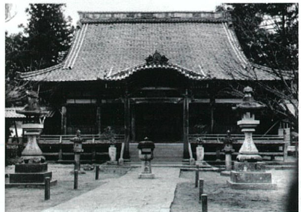
明治修理により改変された棧瓦葺の本堂 「昭和28年本堂修理工事報告書」より
