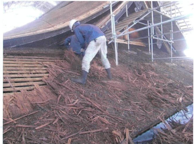
屋根檜皮葺解体状況
