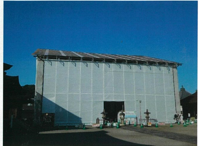
仮屋根建設完了
