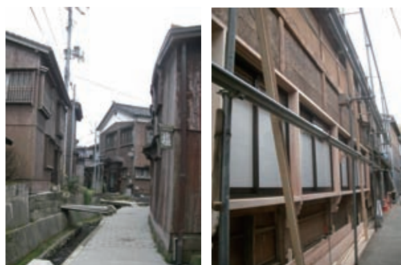
宿根木伝統的建造物群保存地区で進む修理・修景事業
