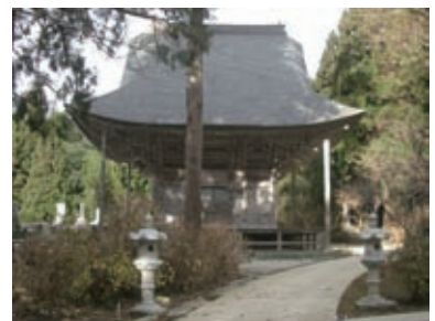
蓮華峰寺八祖堂（組物を五手先とするため、屋根が大きく迫力がある特異な造形となっている）
