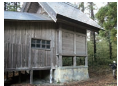
白山神社本殿（基礎部は小泊産の切石）
