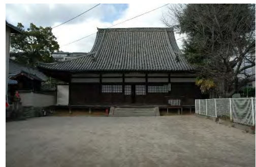
常称寺本堂（重要文化財）
