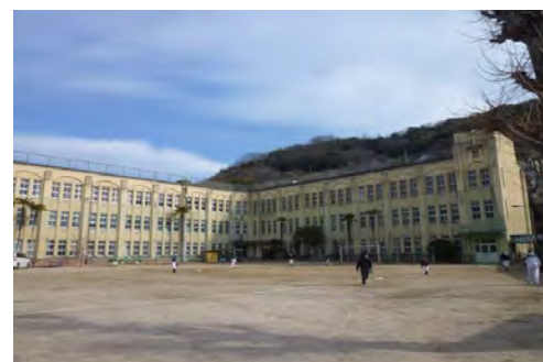
久保小学校（昭和8年建築）
