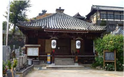
正念寺本堂 (17世紀の建築)
