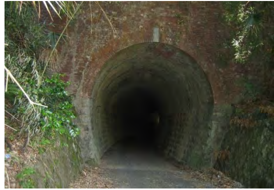
旧尾道鉄道トンネル
