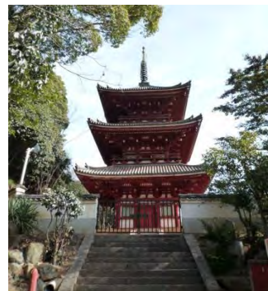
西國寺三重塔（重要文化財）
