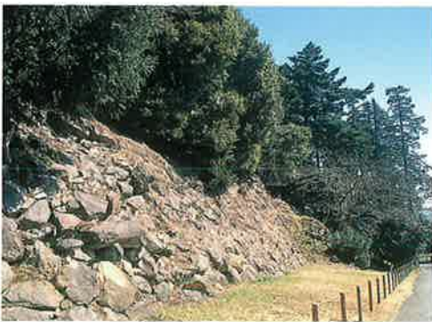
写真8 南曲輪南面石垣全景（西から）
