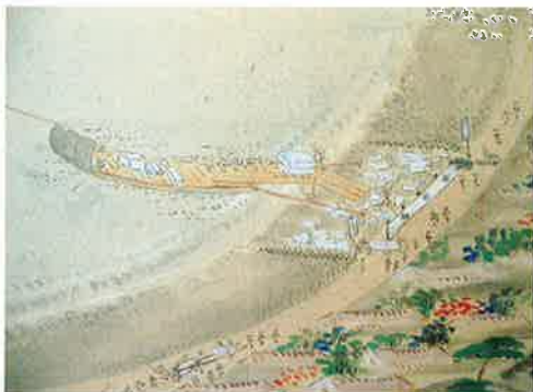
写真39 「石切図」屏風の房丁に石垣用石材を積み込む様子(小田原市郷土文化館蔵)
