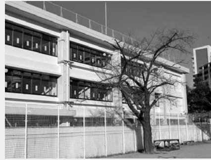
～工事中の現地の様子～
