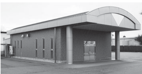
改修工事を行う市火葬場
