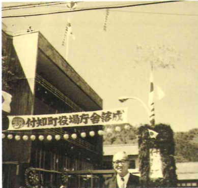
昭和44年 役場新庁舎完成
