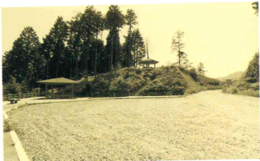
平成6年 広域基幹林道恵北線完成
