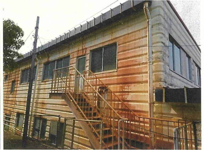
【建物外観（裏側）】
