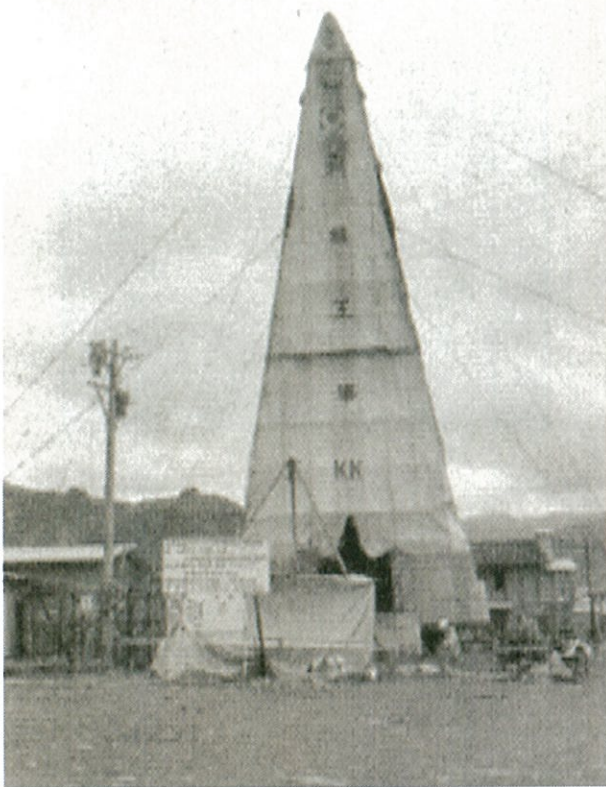
▲松代深層ボーリングコアを掘削するために組まれた樽。この中ではドリルを使って地下を掘り進めて岩石を取り出しています。
