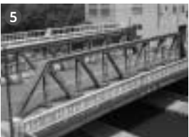
5 木場橋、S4.2、 木場3、トラス
