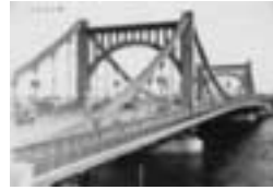
竣工当時の清洲橋(土木学会土木図書館所蔵)
