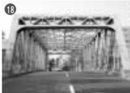
18 東富橋、S5.2、 富岡2~牡丹3、トラス
