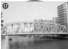
17 西深川橋、S5.2、 森下3~白河1、トラス
