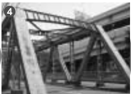
4 鶴歩橋、S3.7、 冬木~木場3、トラス
