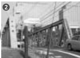
2 平久橋、S2.5、 木場1~牡丹3、トラス
