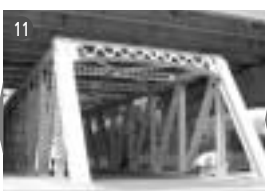
11 松本橋、S4.11、 毛利2~墨田区江東橋4、トラス
