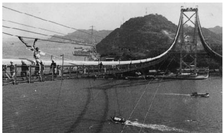
建設中の関門橋
