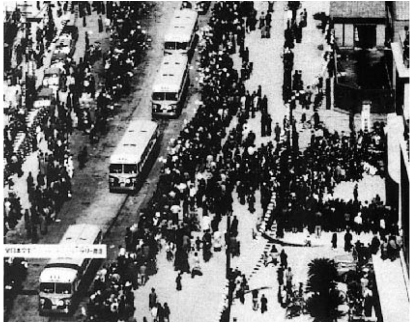
開通の日の大混雑ぶり（トンネル口付近） （「北九州思い出写真館」）
