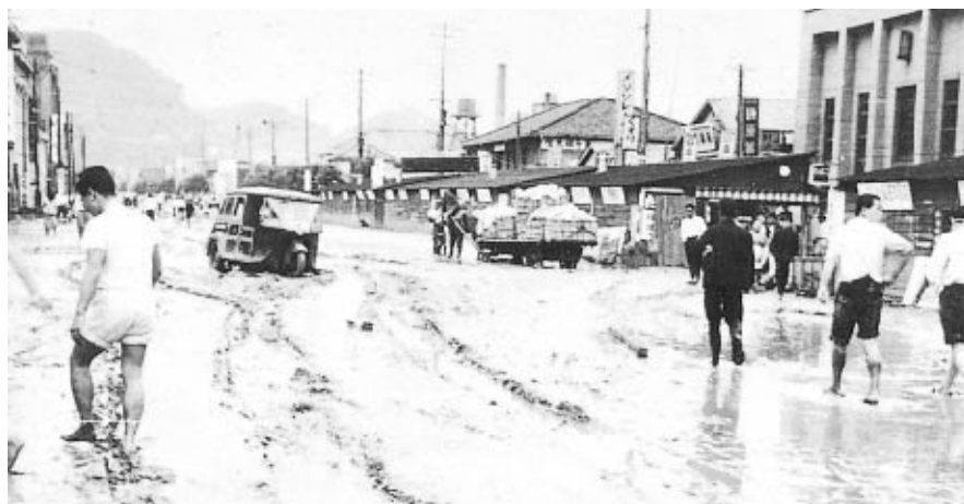
栈橋通り付近
