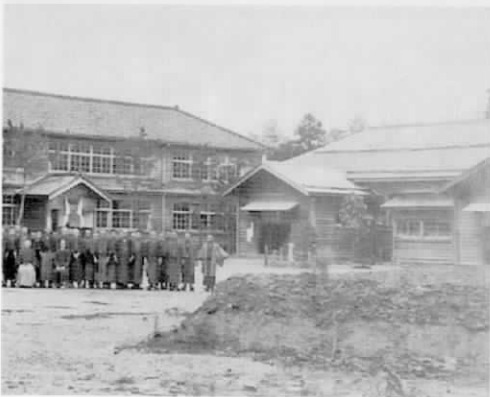
▲ 竣工直前の七谷保育園（上、昭和43年）と大正4年の須田小学校竣工記念写真 屋根の形状や規模は変わっていない。
