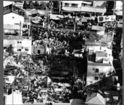
被災後の第二現場
