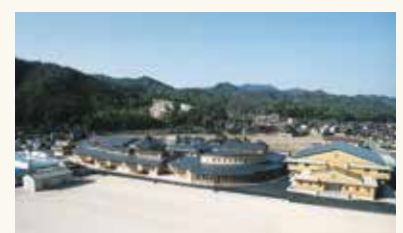
小野小学校新校舎完成(平成16年4月)
