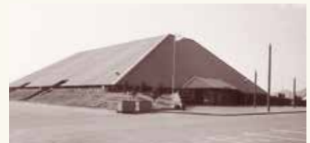
防府スポーツセンター体育館完成(昭和49年3月)
