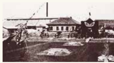
日本専売公社防府製塩試験場設置(明治42年)
