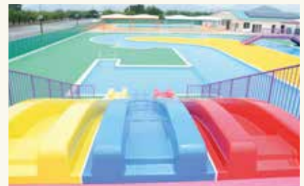
スポーツセンタープールオープン(平成26年7月)
