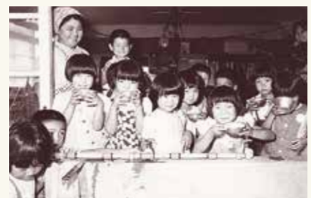
野島簡易水道完成(昭和49年9月)
