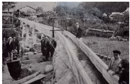
2-1-23 大正5年 北町用水改修工事
