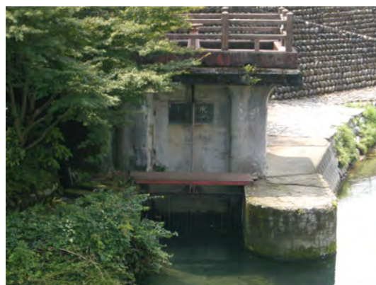
2-1-26 島谷用水取水口 (昭和12年改修)
