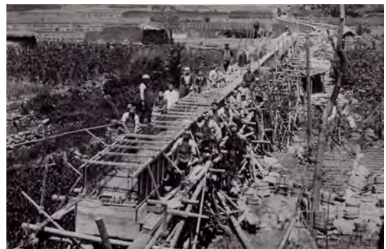
2-1-22 大正5年 北町用水改修工事
