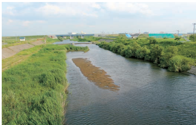
図99 中川地区 旧十川と津軽自動車道「五所川原西バイパス」の工事（上中泊橋より南を望む）
