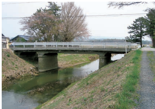
図125 飯詰川と長富橋
