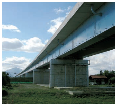
図109 岩木川をまたぐ奥津軽大橋 (津軽自動車道「五所川原西バイパス」)
