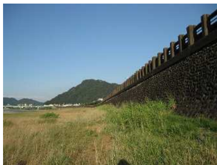
写真I-3-3 忠節橋上流の特殊堤
