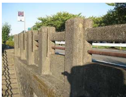
写真I-3-4 特殊堤の手すり
