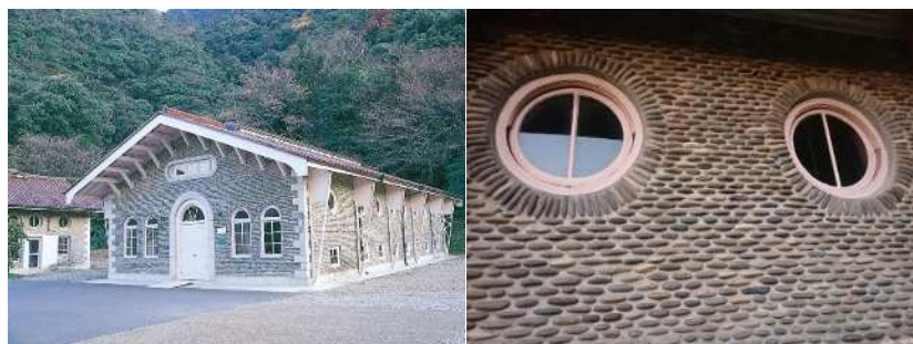
旧エンジン室の外壁と丸窓。外壁に長良川の川原にある自然石を使用。
