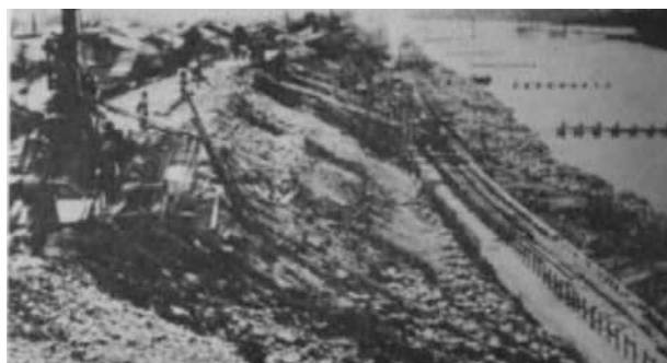
写真 I-3-2 東島地区の堤防改修工事のようす
