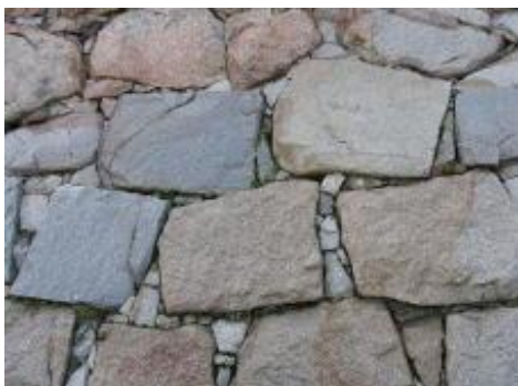
〔天守閣の土台の石垣〕
