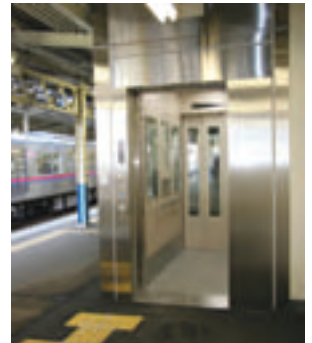
エレベーター整備
