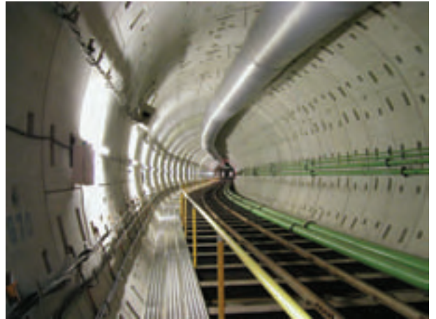
中央雨水1号貯留幹線
