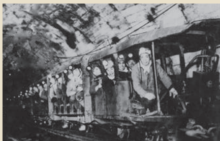
斜坑人車で入坑
