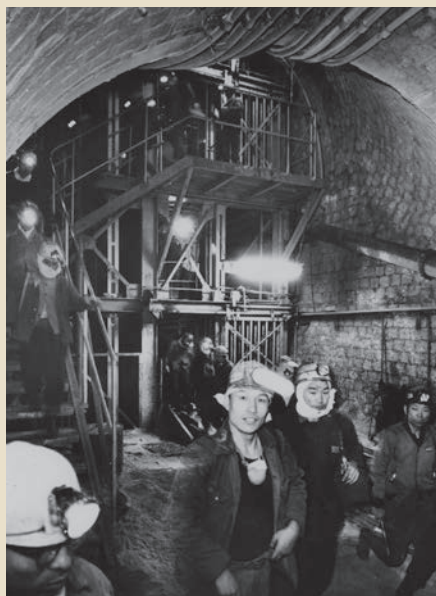
-350水平坑底昇降場の入坑
