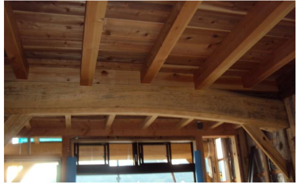
図5 建設中の舟屋の内部
