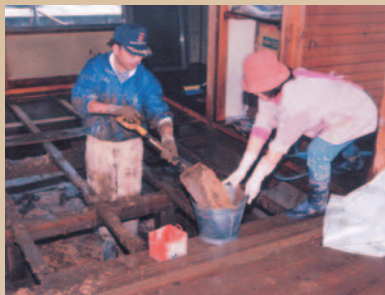
床下の泥を取り除いている様子。
