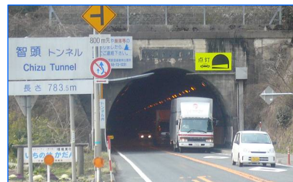
▲国際コンテナ通行支障トンネル(智頭トンネル)
