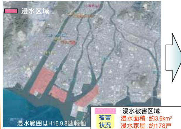
【平成16年9月の台風18号による浸水被害状況】
