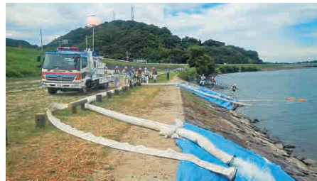
排水ポンプ車による排水訓練
