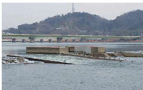
改良後の4号魚道
