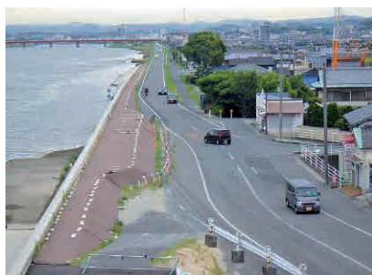
工事実施前 (旭川：江崎)
