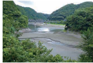
渇水時の旭川ダムの状況
