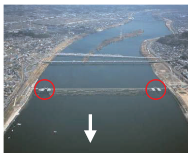
高梁川潮止堰
