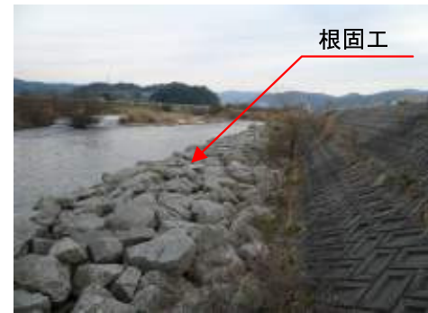
「根固工」の施工例 (低水護岸の前の石積み)
