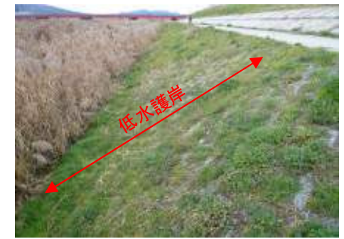
「低水護岸」の施工例
