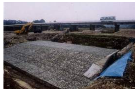
河岸侵食防止工の施工例(小鴨川)
