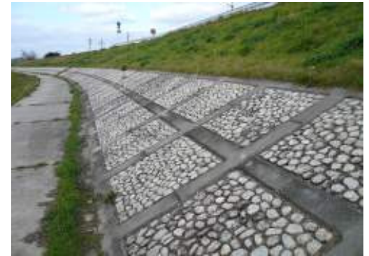
高水護岸の施工例
