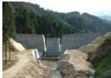
スリット型砂防堰堤 (堀3号堰堤)
