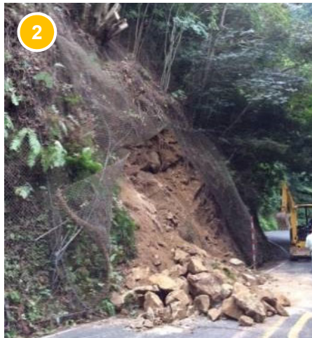
【国道414号 法面崩壊】 (2015.9 河津町峰)
