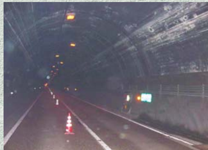
壁面の車両の接触痕
