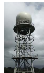
八重岳レーダ雨量計（沖縄県）
