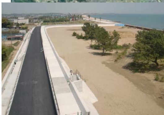
栗真町屋工区 工事状況
