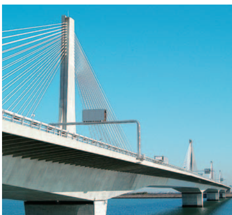
2002年3月、伊勢湾岸自動車道、湾岸弥富IC～みえ川越IC開通
