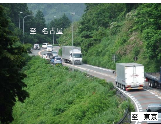
写真 国道246号 2車線区間(H26.6)
