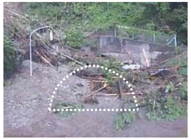
トンネル坑口を閉塞する土砂
