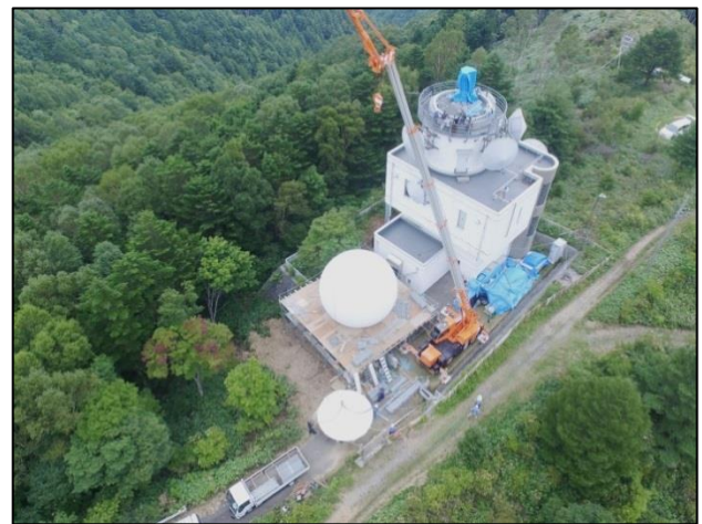
図3-2 蛇峠レーダ雨量計の施工場所
