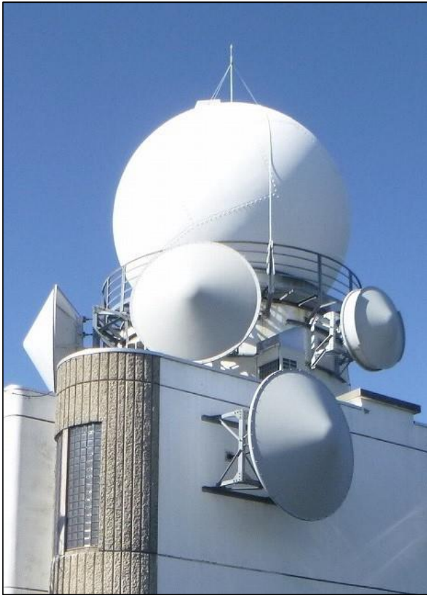
図3-3 施工完了時のレーダ雨量計
