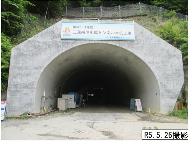
T N 坑口 (長野側)
