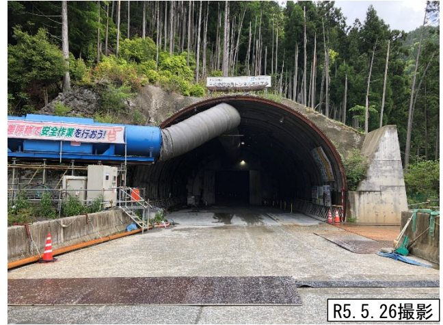
T N 坑口 (静岡側)
