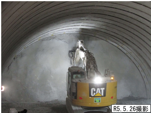
トンネル内 (貫通前の掘削)
