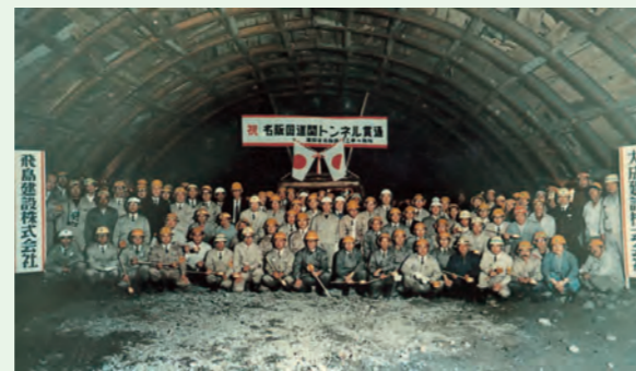
関トンネル(昭和 47 年 4 月 22 日)
