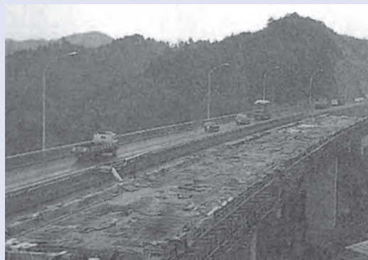
二期工事(伊賀大橋)
