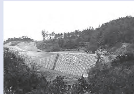
名阪国道・木下道路の工事
