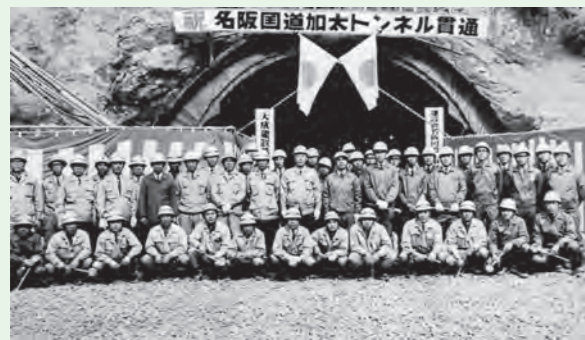
加太トンネル(昭和 45 年 4 月)
