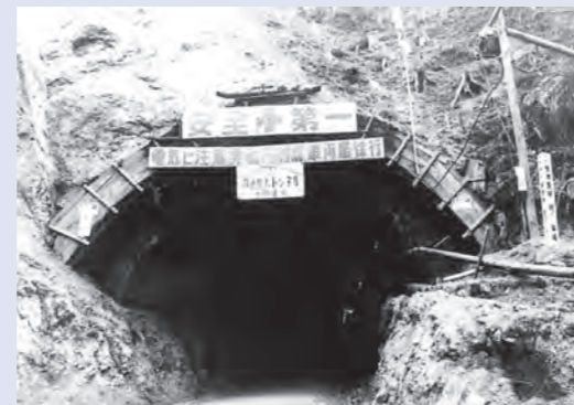
加太トンネル貫通
