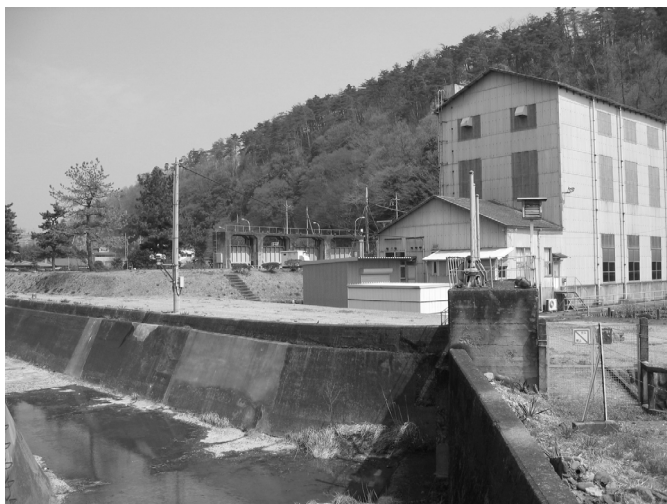
写真3-2 広瀬・桃木分流口の現況
