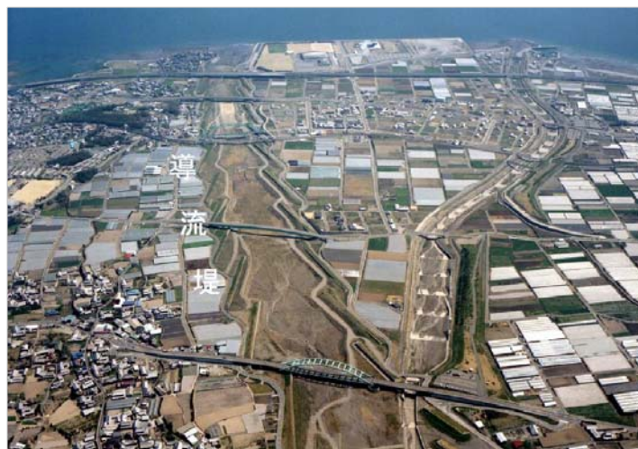
写真 6-7 安中三角地帯のかさ上げ (2004年3月 国土交通省雲仙復興事務所提供)
