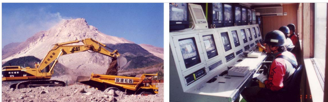
写真 6-6 無人化施工 (撮影 松井宗広 1994年4月11日)
