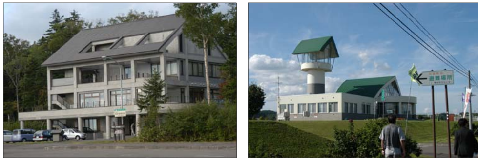
写真 5-6 （左）白金温泉の十勝岳砂防情報センター （右）国道脇の農地をかさ上げして造られた草分防災センター
