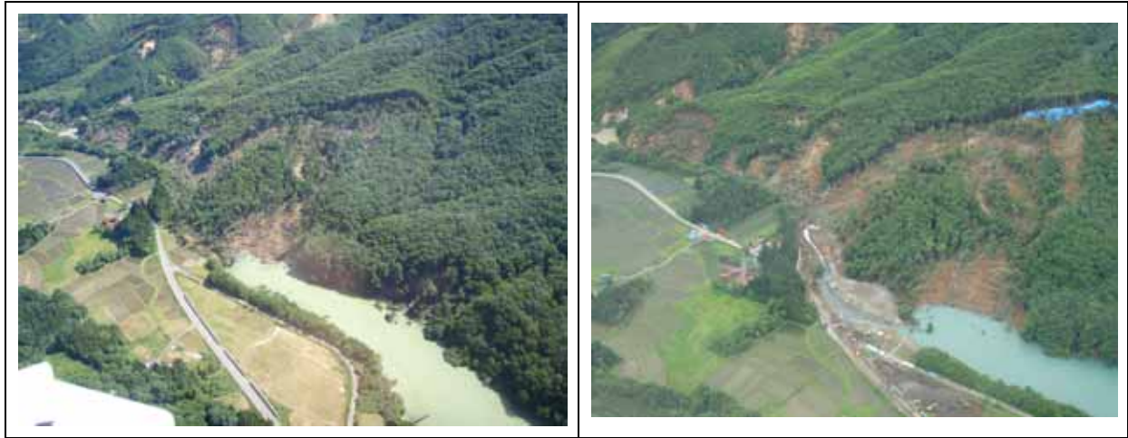
図 （対策工事の例）平成 20 年岩手・宮城内陸地震における 磐井川（一関市 市野々原地区） 左：地震直後 右：対策工事
