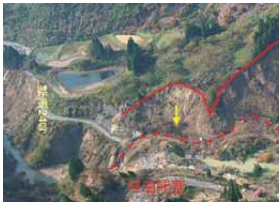
図 長岡市(旧山古志村)の河道閉塞（新潟県中越地震）
