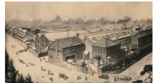
日本精工大崎工場
