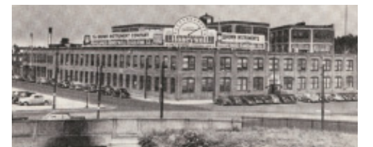
ブラウン社 (2階建ての部分、屋上の広告は後のもの)
