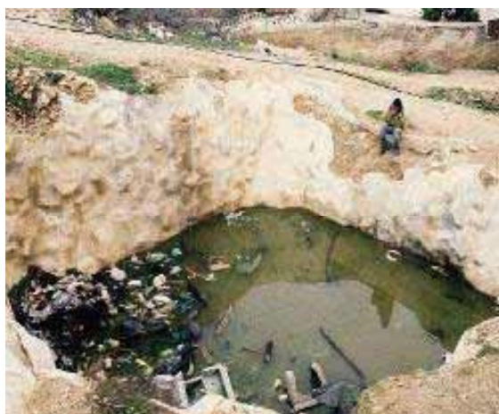
【写真右】許可されていなかったため、イスラエル軍に壊された雨水貯水槽 ©AI
