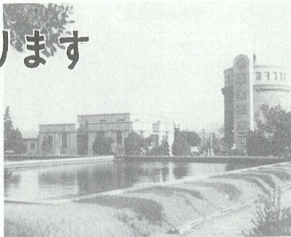
岡崎市水道の創設 六供浄水場 昭和8年5月完成
