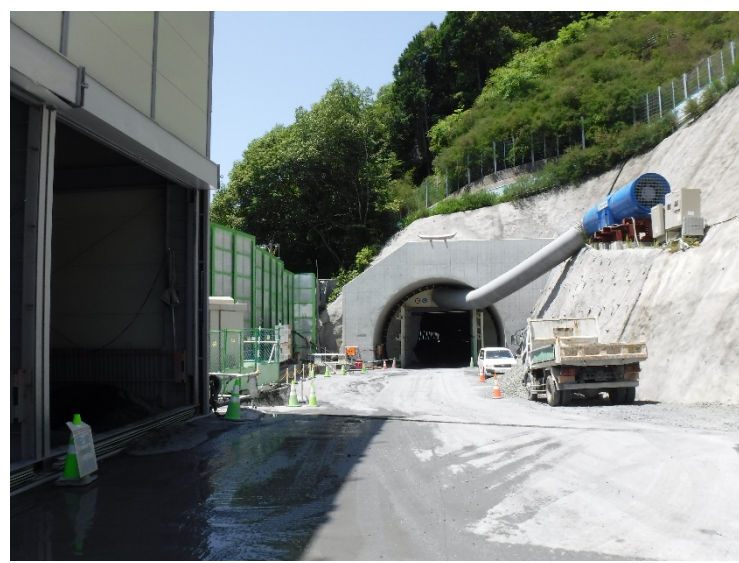
下敷水トンネル（下敷水地区） R4. 6時点
