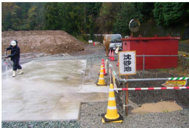
沈砂池の設置
