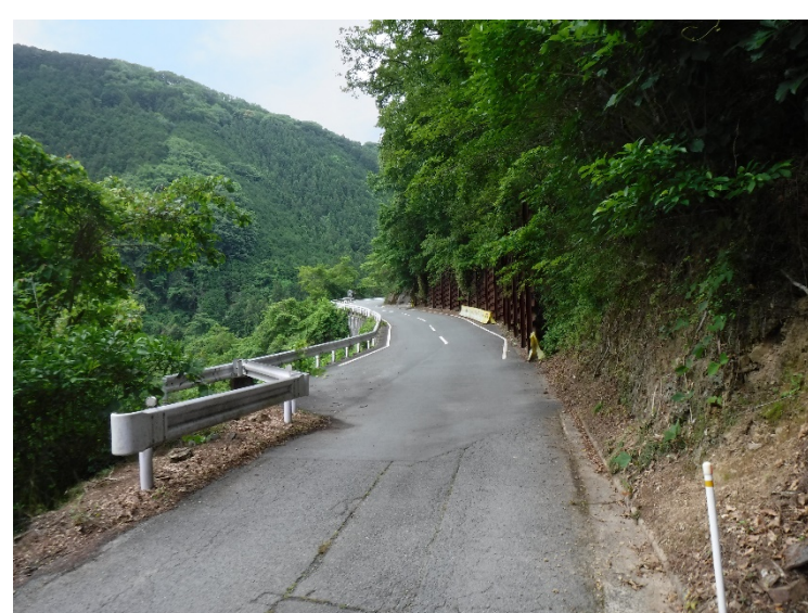
工事用道路（月野尾地区） R4. 6時点
