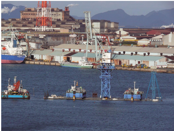
写真 12 沈設前の沈埋函
