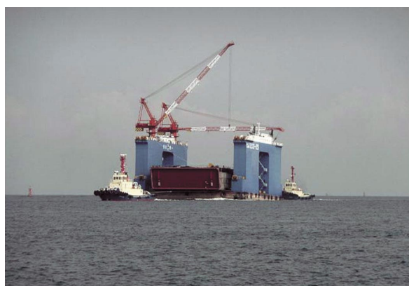
写真 8 沈埋函鋼殻曳航状況
