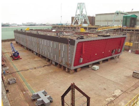
写真 7 沈埋函鋼殻陸上製作完了
