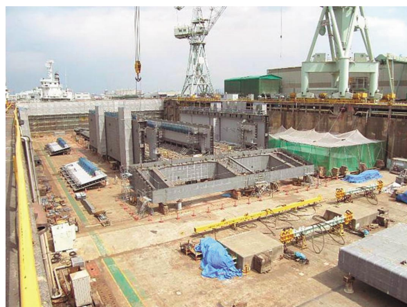
写真 6 沈埋函鋼殻陸上製作状況
