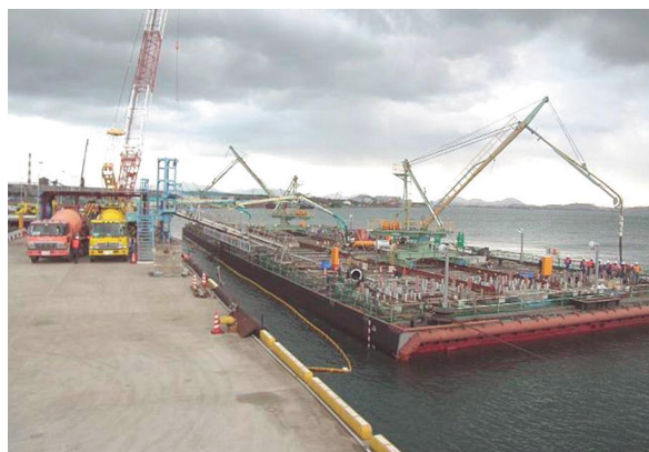
写真 9 充填性コンクリート浮遊打設状況
