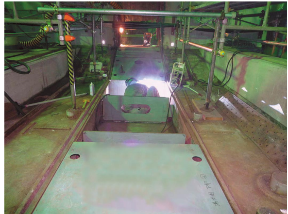
写真 13 剛継手施工状況
