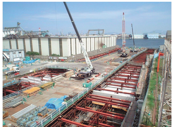
写真 14 若松側陸上部施工状況
